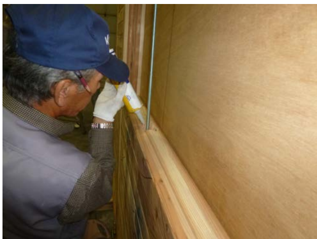
シーリング材の施工
