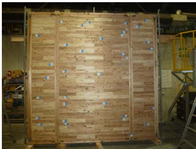
軸組み及び木製ブロック施工状況
