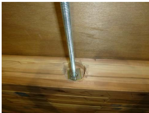
シーリング材施工状況
