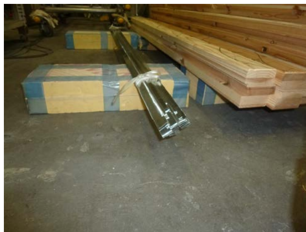
接合金具 1(柱ー木製ブロック 接合用)
