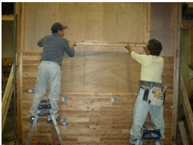
中間材の施工
