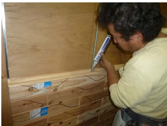
シーリング材の施工
