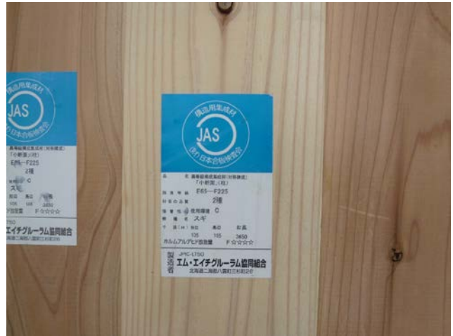
柱材 すぎ集成材 105×105 mm
