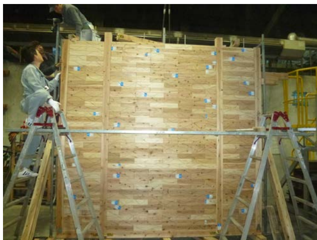
木製ブロック施工状況
