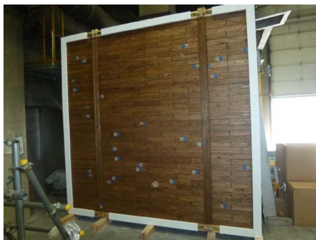
木材保護塗料施工状況
