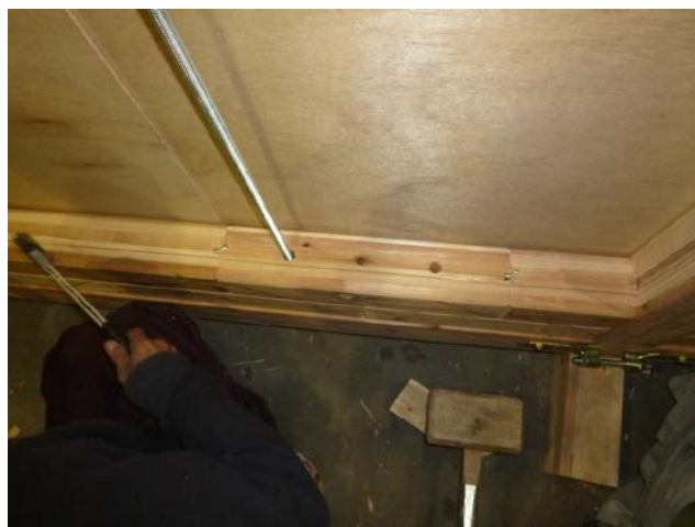
木製ブロック施工状況
