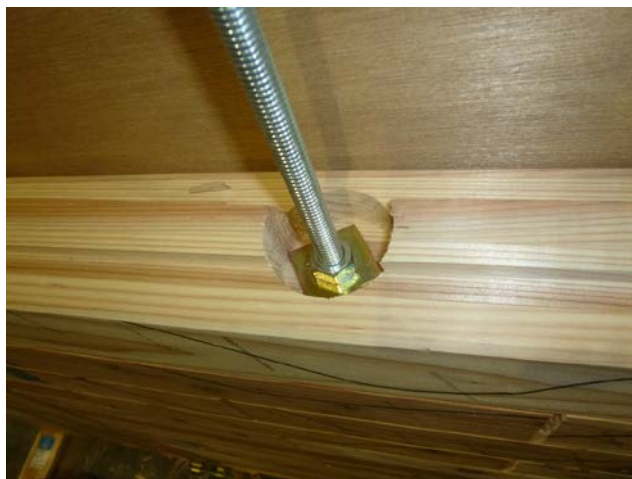
六角ナット及び角座金の施工状況
