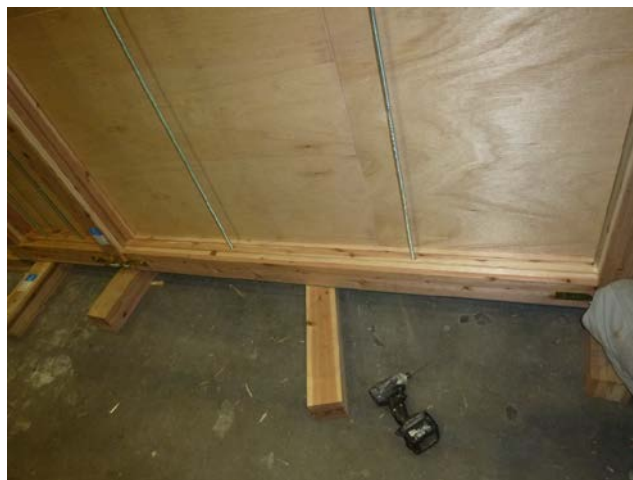
接合材の施工
