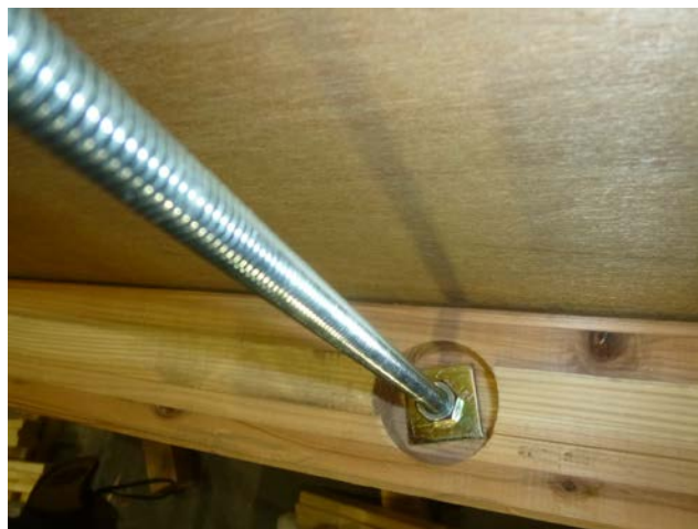
六角ナット及び角座金の施工状況
