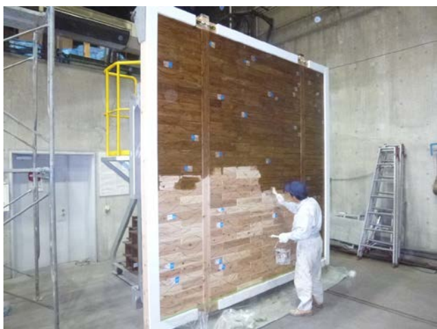
木材保護塗料の施工
