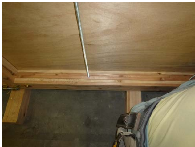
接合材の施工
