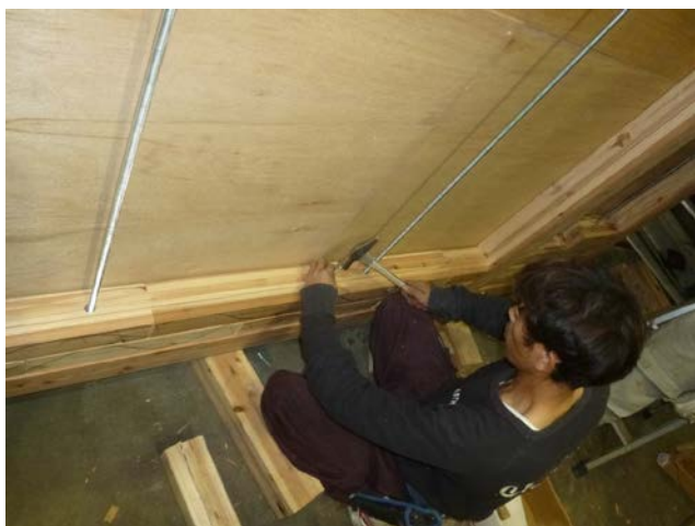
接合金具の施工
