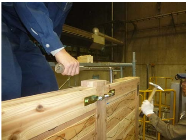
桁の施工状況
