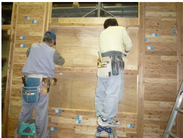
中間材の施工
