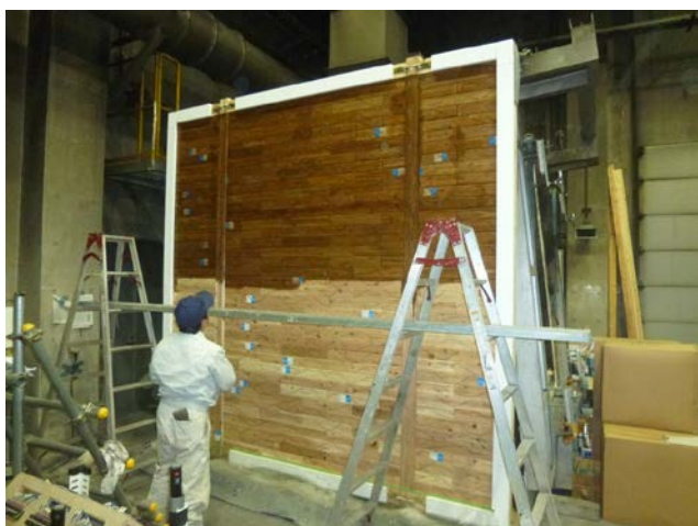
木材保護塗料の施工
