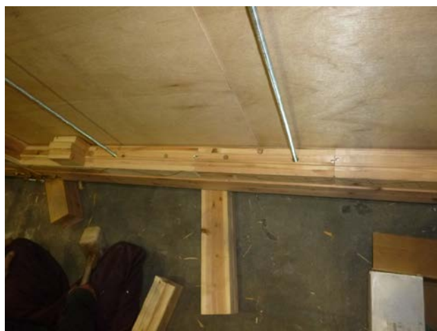
木製ブロックの施工
