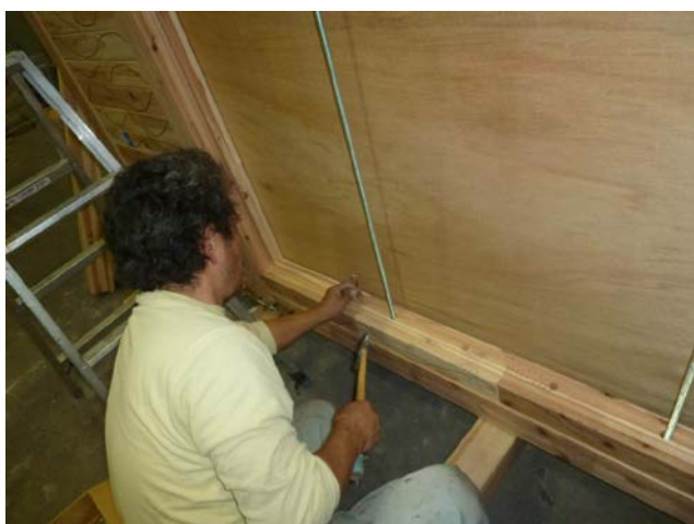
接合金具の施工
