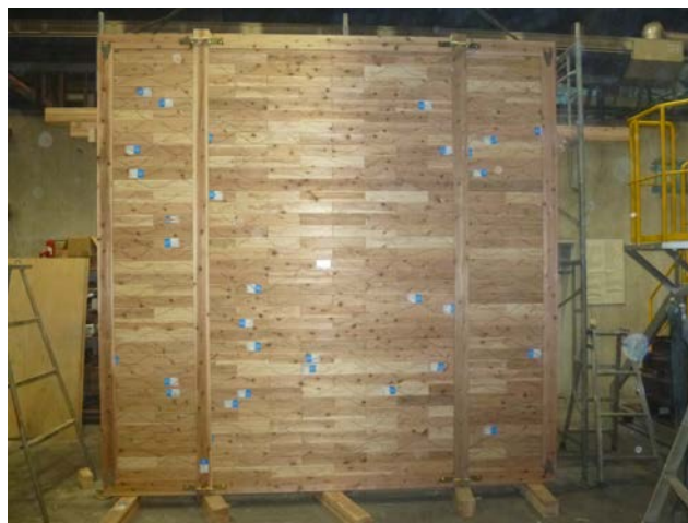
軸組み及び木製ブロック施工状況
