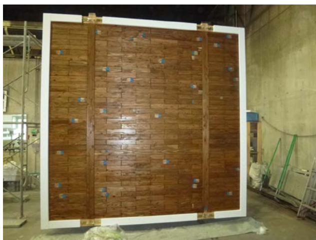
木材保護塗料施工状況
