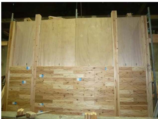
長ナット施工状況
