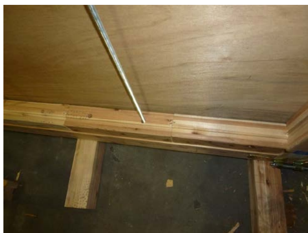
木製ブロック施工状況
