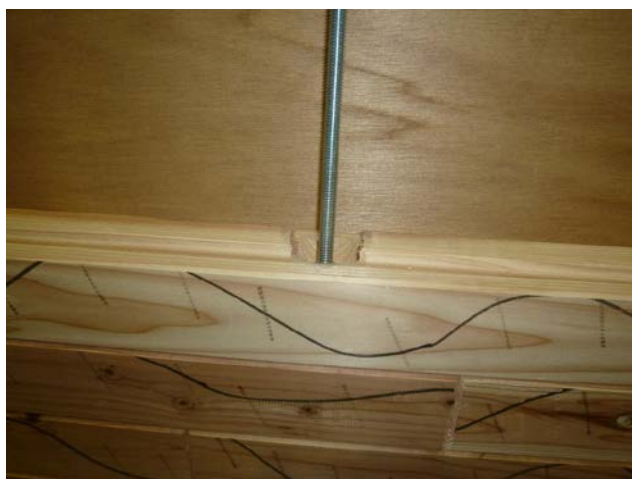
シーリング材施工状況
