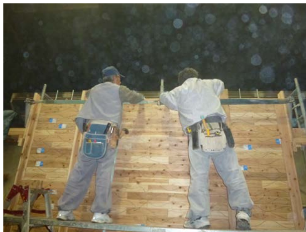
木製ブロック施工状況
