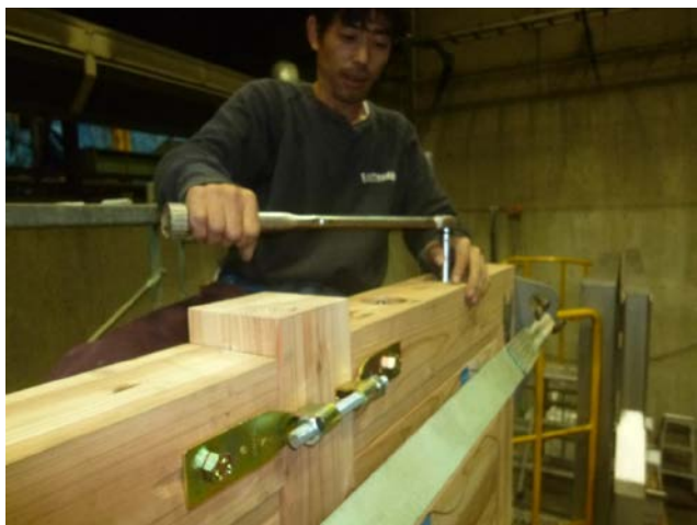
桁の施工状況
