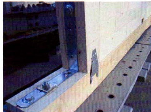
写真9 試験終了後の様子(No.2) 左柱脚部の様子
