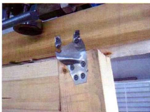
写真 17 試験終了後の様子(No.4) 右柱頭部の様子
